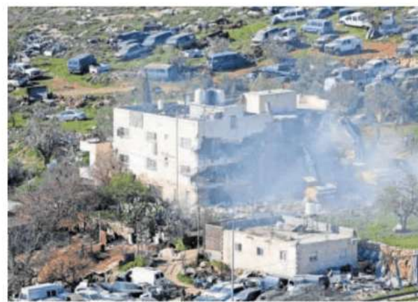
Demolición de un edificio ayer en Hebrón. MUSSA QAWASMA (REUTERS)
